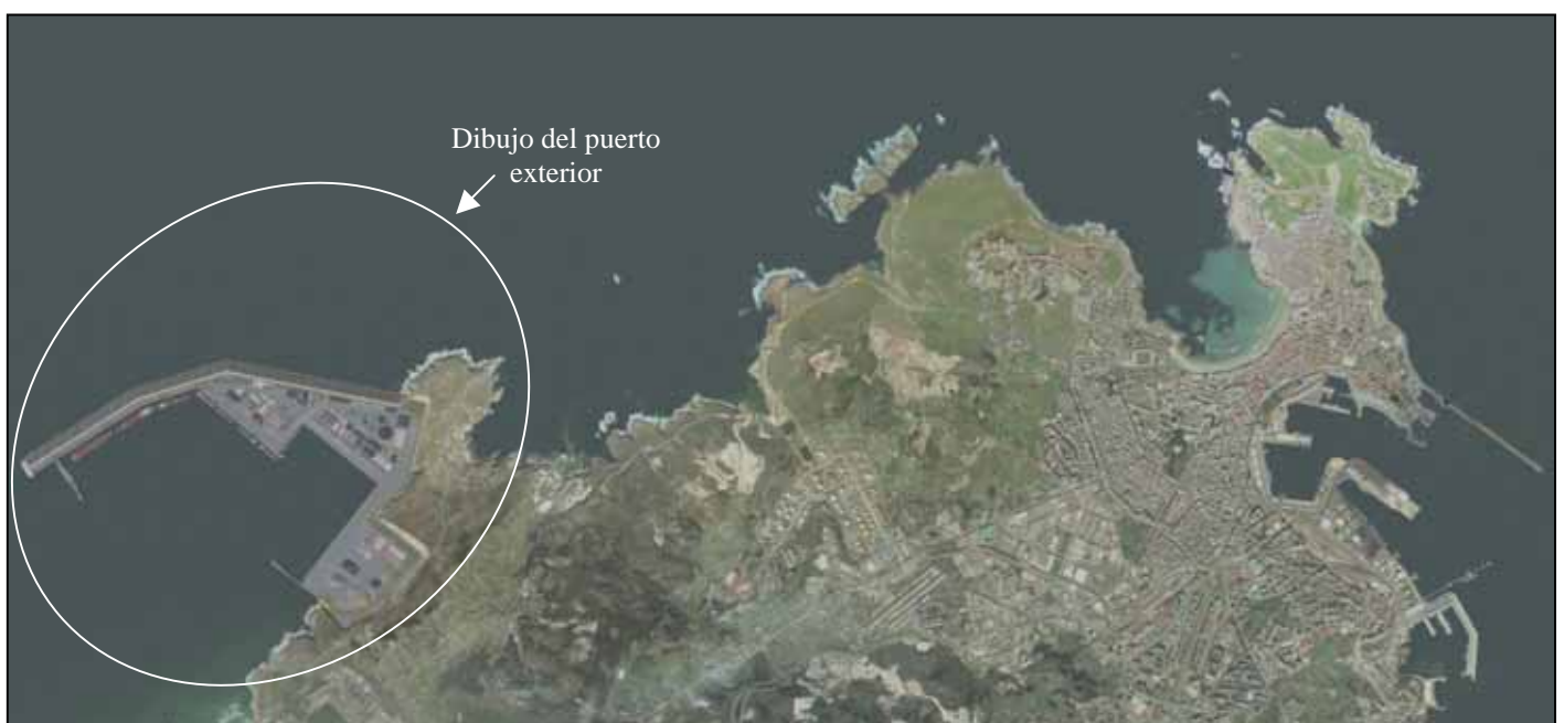
Fotografía aérea del puerto de A Coruña y dibujo de su puerto exterior
