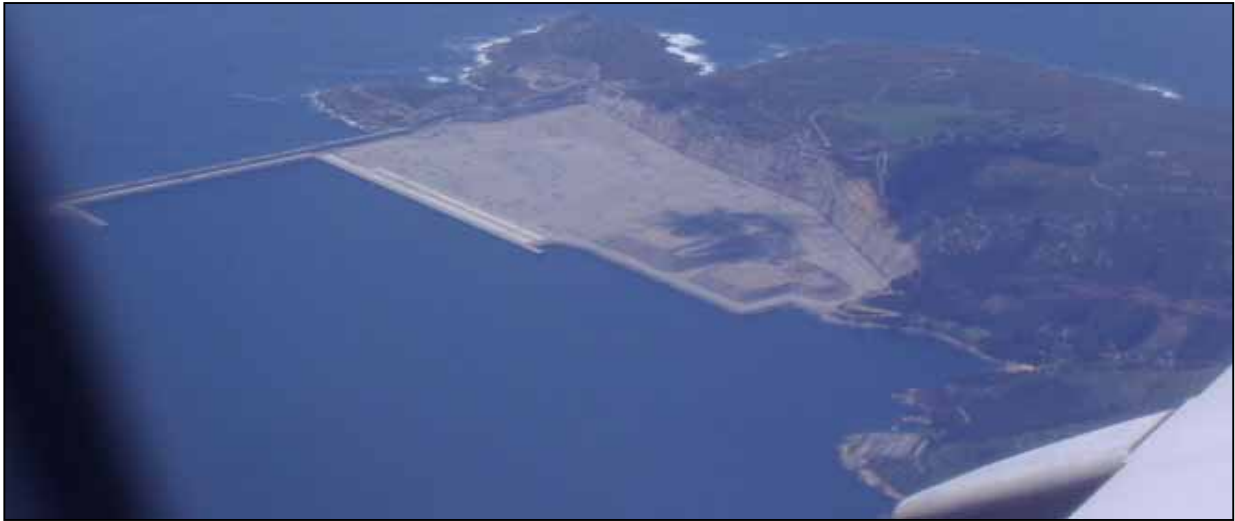
Fotografía aérea del puerto exterior de Ferrol en construcción
