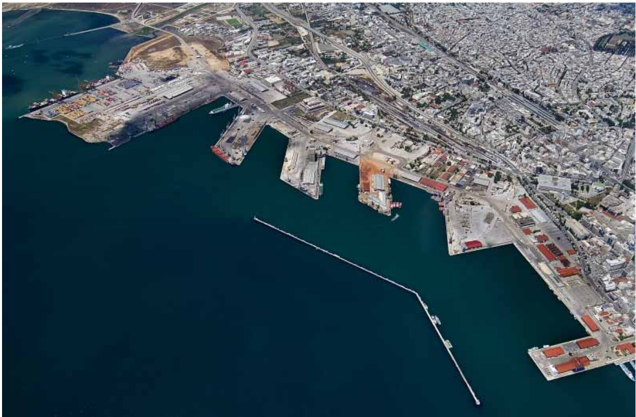
Puerto de Tesalónica (Grecia)
